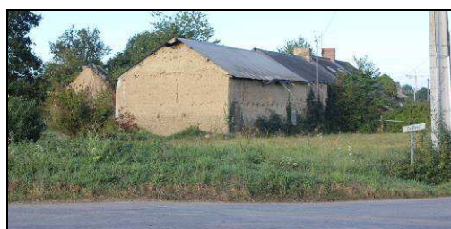
Le Breil : bâtiment agricole de terre crue (bauge).
