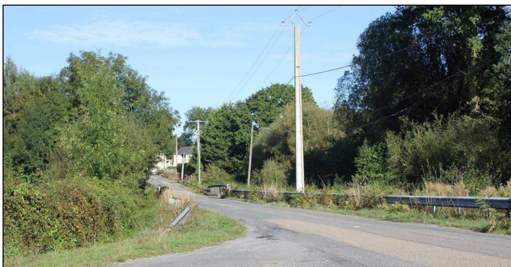
Franchissement du Combs.
